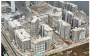
工事が着々と進む晴海の選手村。大会開催後は分譲マンションとして改修し販売されるといいますが...
