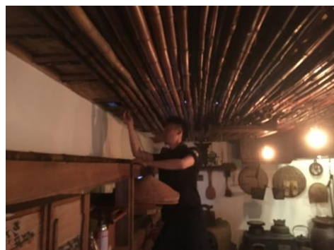
⑧天井作業は足腰に負担が掛かります
