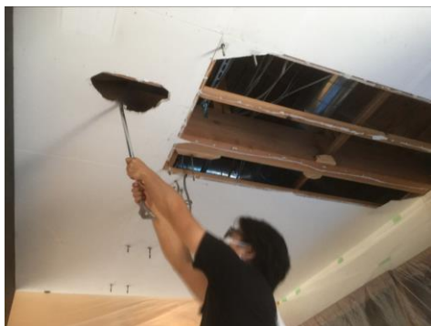
②2017年6月22日 天井の石膏ボードを取り壊し開始
