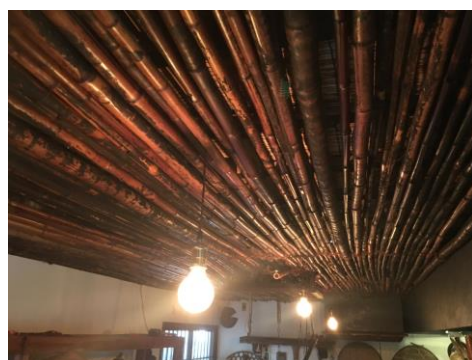
⑪2018年7月5日 煤竹敷き詰め作業完了
