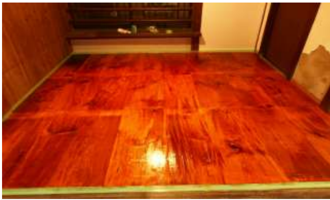
1階居間 古材の天井板を床板として使用
