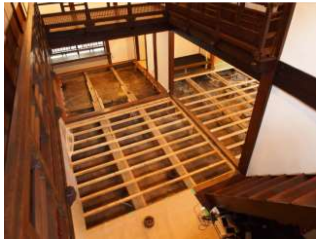
家の傾き修復 2016年9月21日
