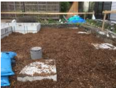
おがくず、呼吸する土を敷き詰めます
