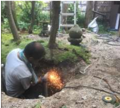
埋まっていたパイプ管を機材でカット
