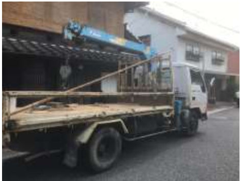
抜き出したパイプ管 全長 6m
