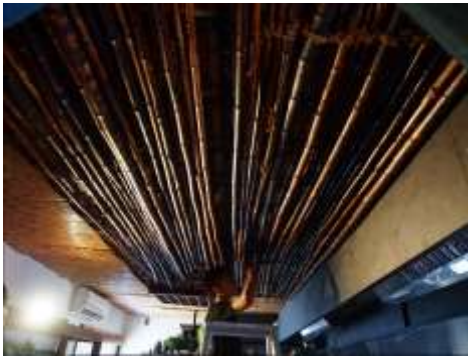
煤竹を紐で結び天井を敷き詰めます
