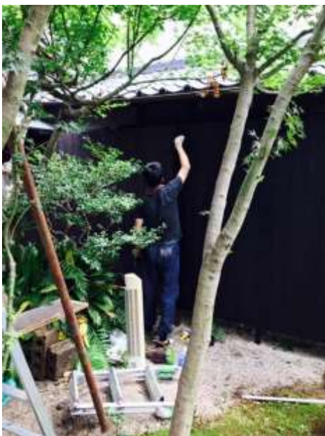
外壁をべんがらで塗装
