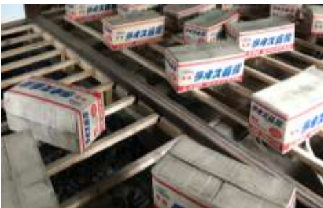
床下に潜り炭を敷きつめました
