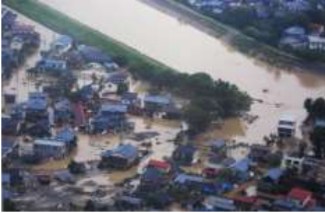
豪雨により堤防が決壊
