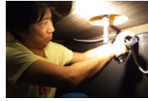
水漏れしていた洗面の配管も修繕していただきました!
