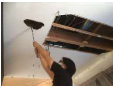
石膏ボードを取り外しています
