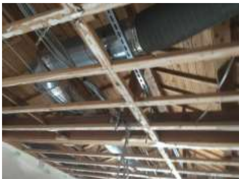
天井に煤竹を敷き詰める予定です
